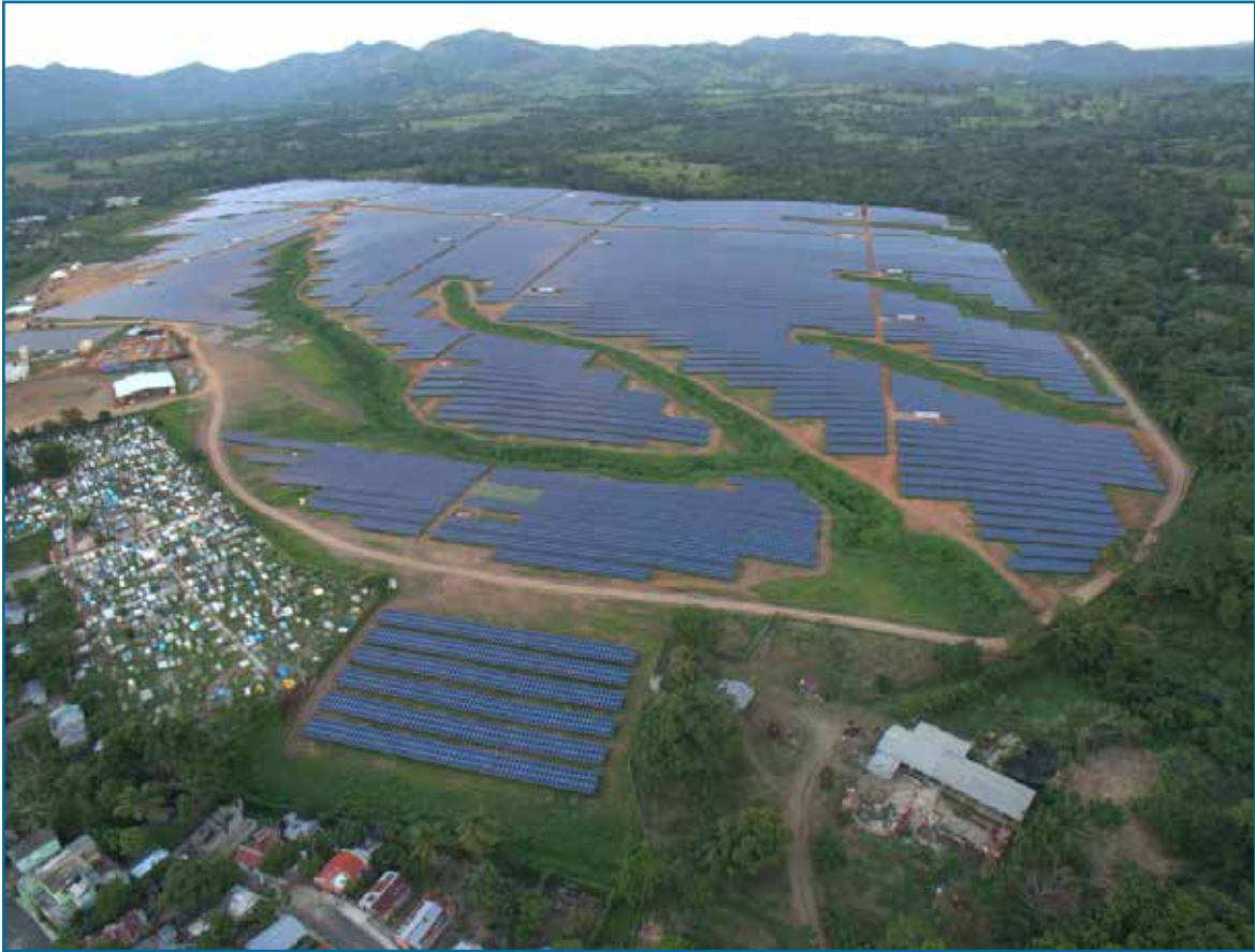
Parque solar de Monte Plata en República Dominicana, con capacidad para generar 30 mW en su primera fase
