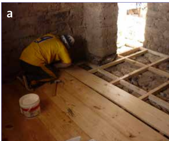
Figura 21. Técnicas bioclimáticas aplicadas en pisos y paredes: (a) Piso aislado higrotérmicamente y (b) Imagen infrarroja de pared radiante. Fotos: CER-UNI
