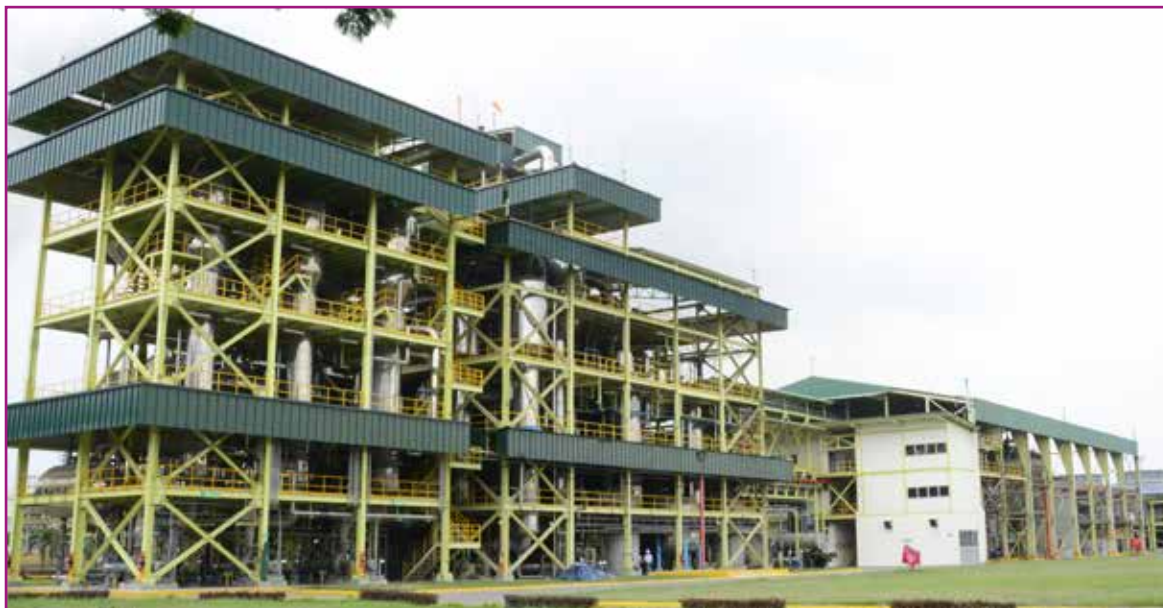
Figura 4. Planta de bioetanol en el Ingenio Providencia en Cerrito Valle del Cauca, Colombia
