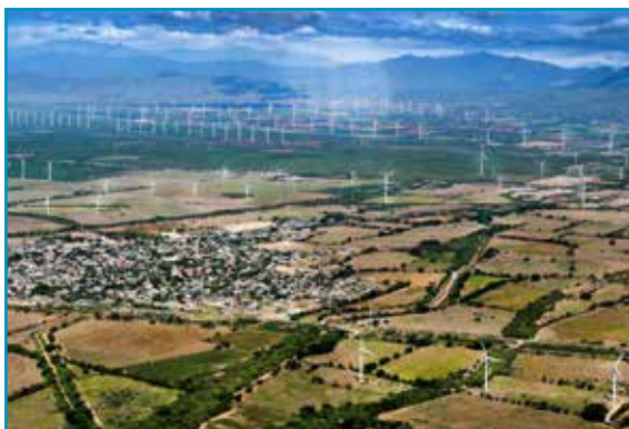
Planta de energía eólica en La Ventosa, Oaxaca.
