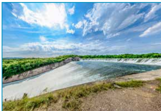
Planta hidroeléctrica de Sanalona, Sinaloa.
